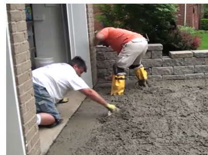
34-how to pour concrete driveway
